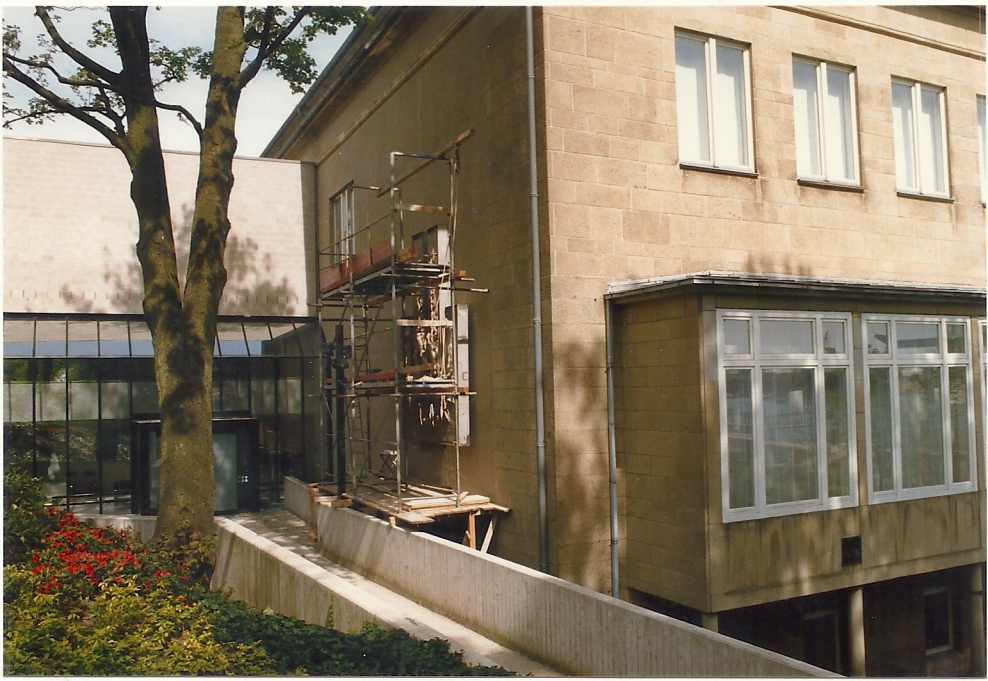
III. Wiedereinbau der Ornamentik an der Kunsthalle Kiel
