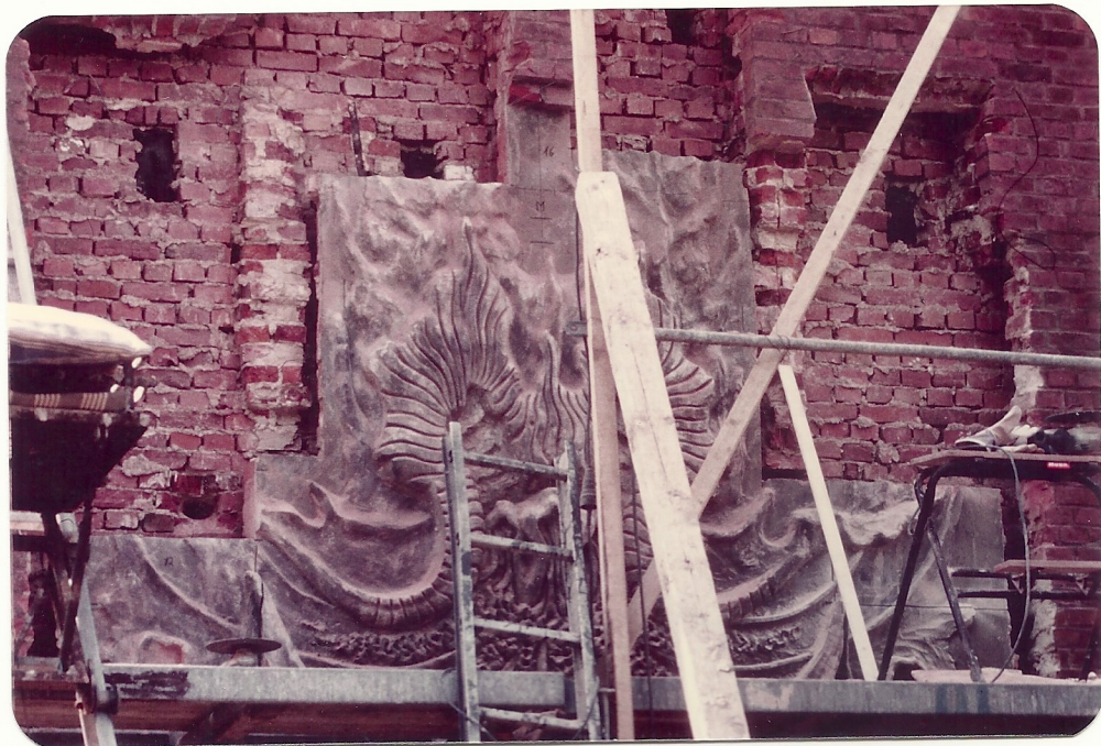
II.a. Nordsee-Sanatorium Wyk auf Föhr Abtragung des Ornamentes von der Nordseite des Sanatoriums.
